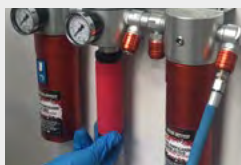
2. Desenrosque el filtro usado
